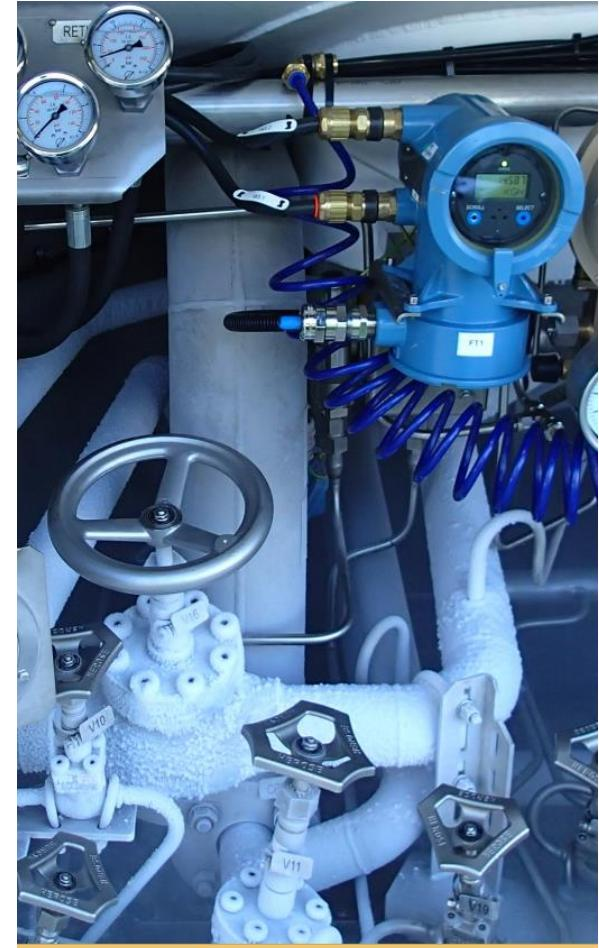
Coriolis bruk på kai for måling ut av produksjonsanlegg til skip og trailer med gassretur. Også inn og ut av selve skipet (Pioneer Knutsen)
