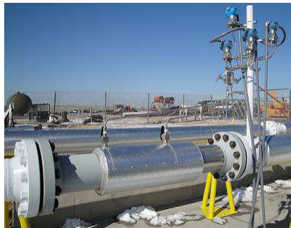
Fig 24. 8",sch 80, 0.60 \beta Venturi meter.
